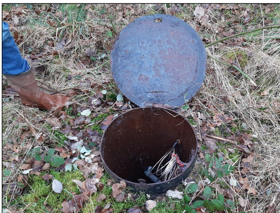
Figure 8 : Photographie de l'ouvrage réalisée lors de la visite de site du 25 janvier 2022
