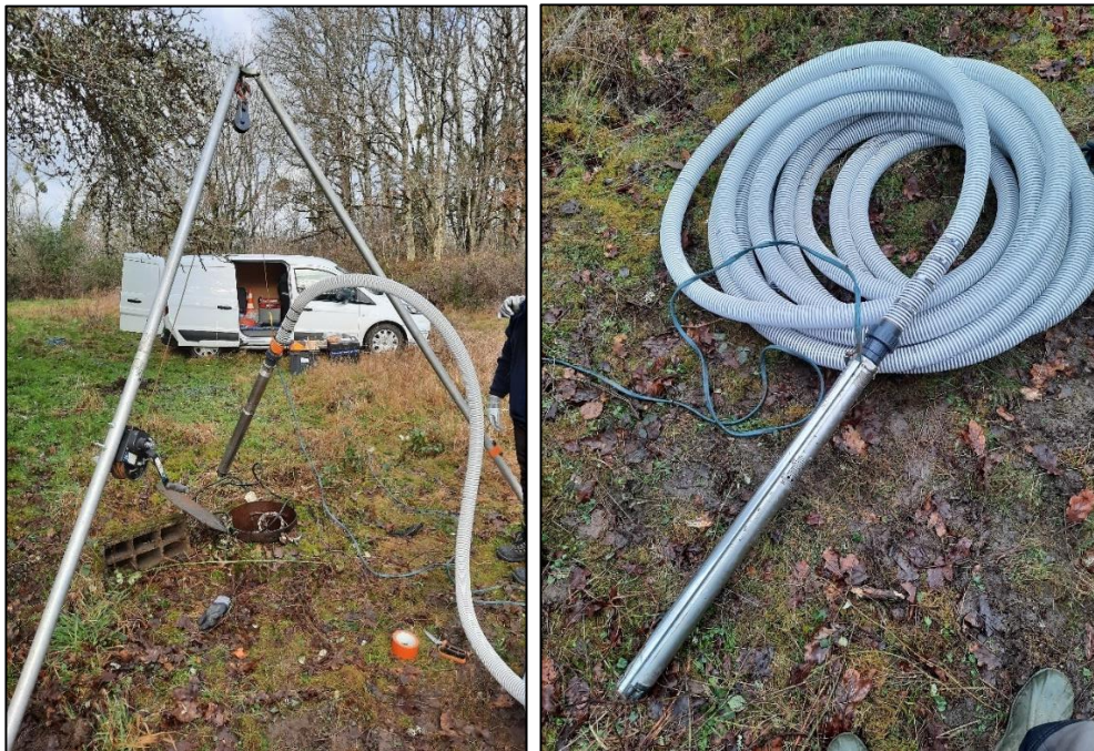
Figure 9 - Matériel utilisé pour l'essai de pompage
