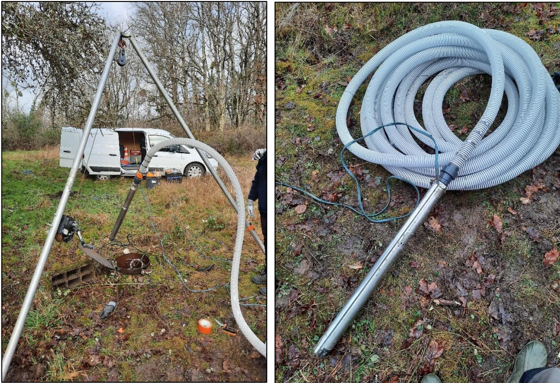
Figure 15 - Matériel utilisé pour les pompages
